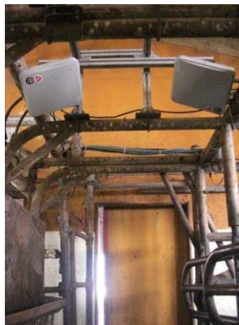
写真8 機器設置状況 (C 牧場)
