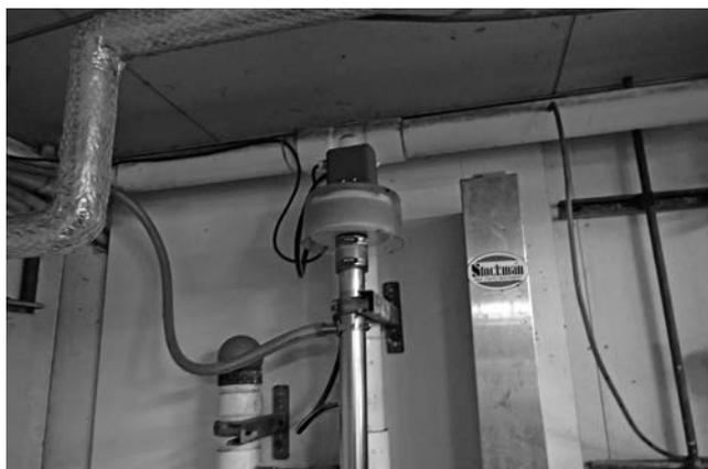
写真2 調圧器 (レギュレーター)
