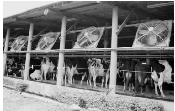
牛舎外部 2頭に1台の割で大型ファンが
