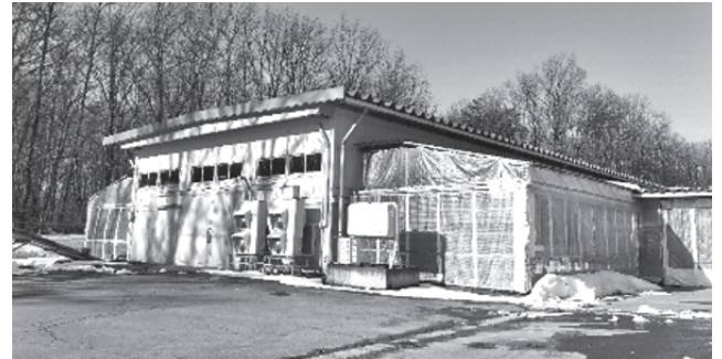
冷暖房を完備した牛房施設（盛岡種雄牛センター）
